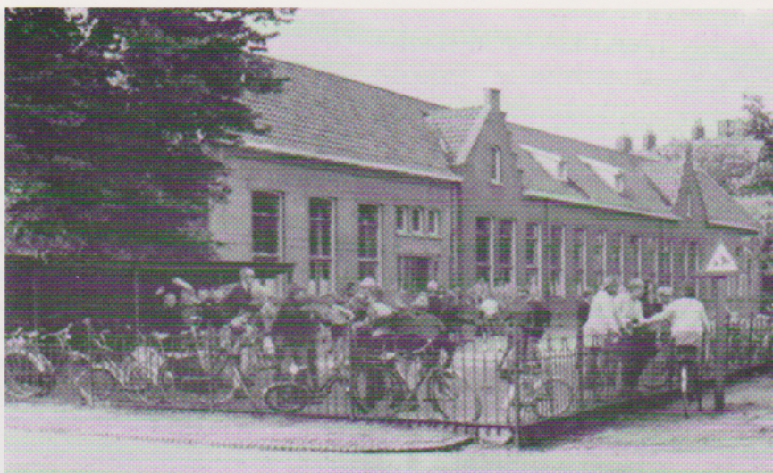
De Ned. Hervormde school, gebouwd in 1880.
