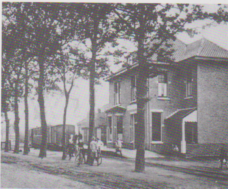
E.D.S. tramstation aan de Looweg.
